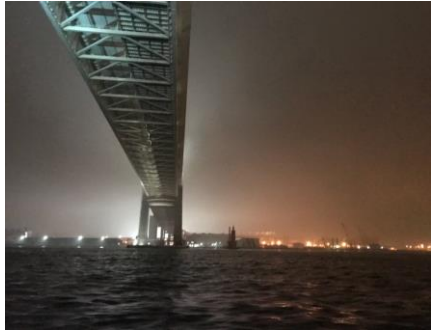
横浜ベイブリッジを下から
